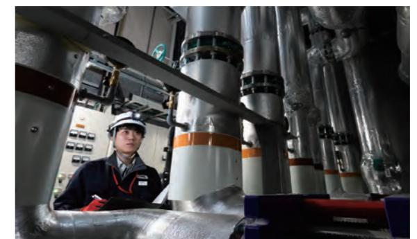
「北ガス札幌発電所」の発電による排熱を利用する熱源設備。日々の点検で安定稼働を維持し、冬でも快適に働ける環境をついている
