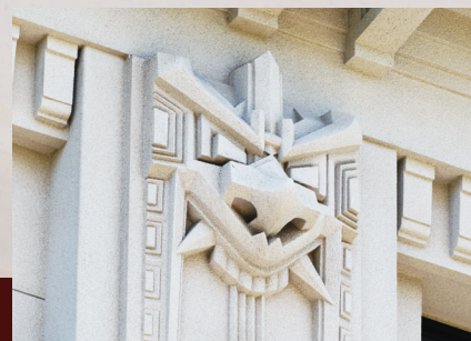
正面玄関柱上部の「鬼神面」の装飾。もともとは石膏で作られていたが、今回の復原に際して3Dプリンタを用い、GRCで作直した
