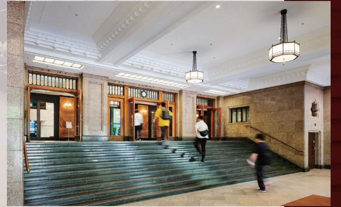
創建時の重厚な雰囲気が残る玄関ホール。床・壁には当時と同じ大理石を用いているほか、天井にも風合いの近い建材を使用している
