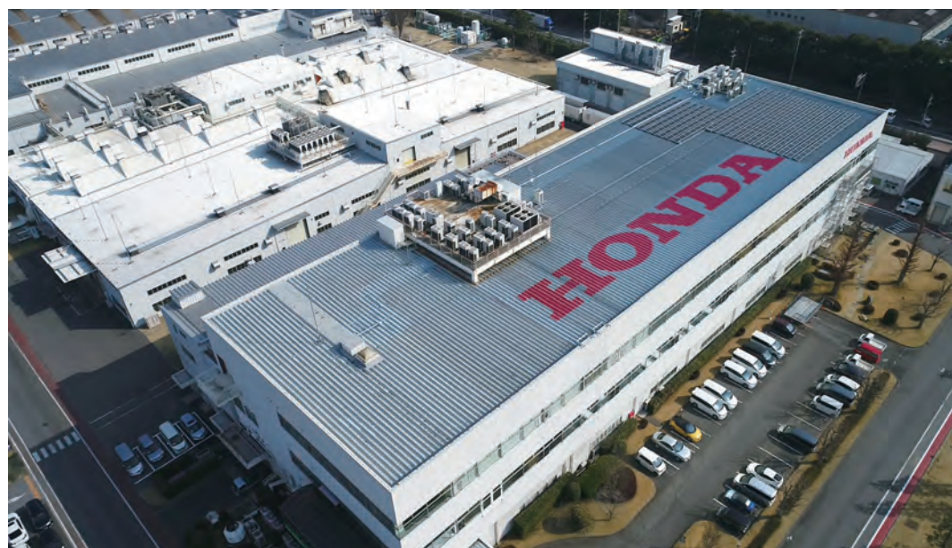
本田技研工業（株）パワートレインユニット製造部 生産工場
