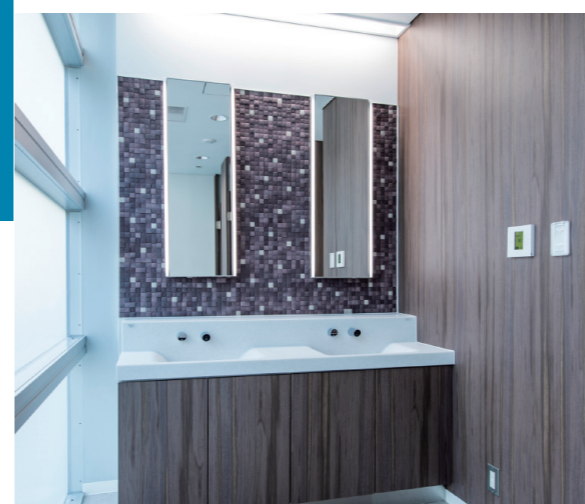
トイレ内装改修
