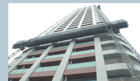
検討の末、採用された移動昇降式足場
